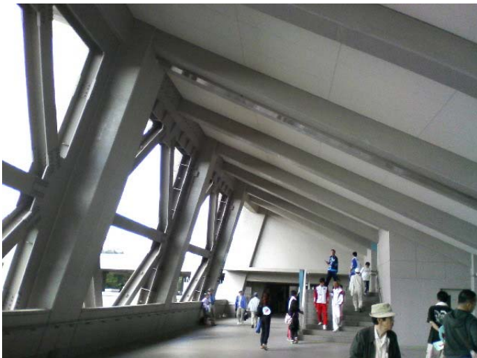
構造補強（コンコース側から）
