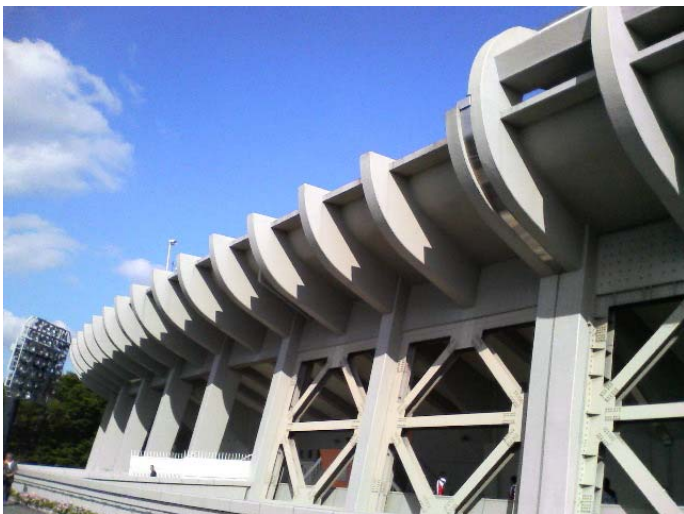
構造補強（外側から）
