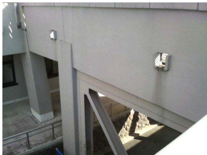
雨水の排水口
