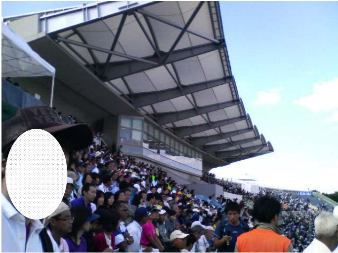
増設された屋根
